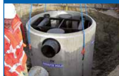
Afwatering bedrijfsterrein Kloosterzande
