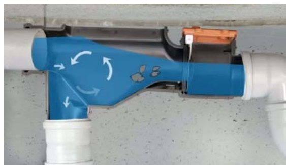
Fig. 2: Filtratie met hydraulische sprong
