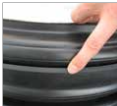
Plaatsen van de afdichtingsring tussen de eerste en tweede golving en insmeren met smeermiddel
