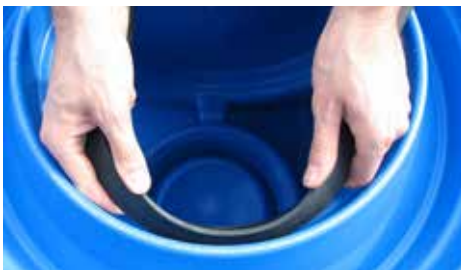
Plaatsing van de afdichtingsring in de buisaansluiting
