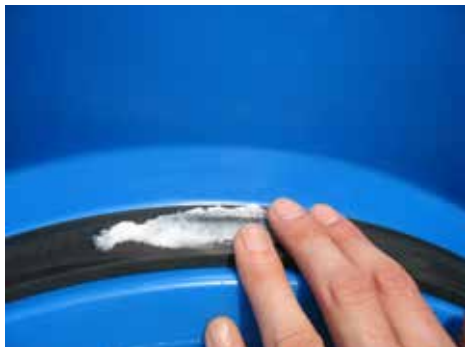
Insmeren van de afdichting met smeermiddel
