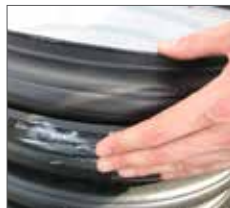
Plaatsen van de afdichtingsring tussen de eerste en tweede golving en insmeren met smeermiddel
