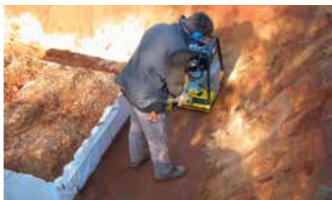
Verdichting van de werkzone naast het bekken
