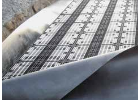
Opvangbekken met geomembraan
